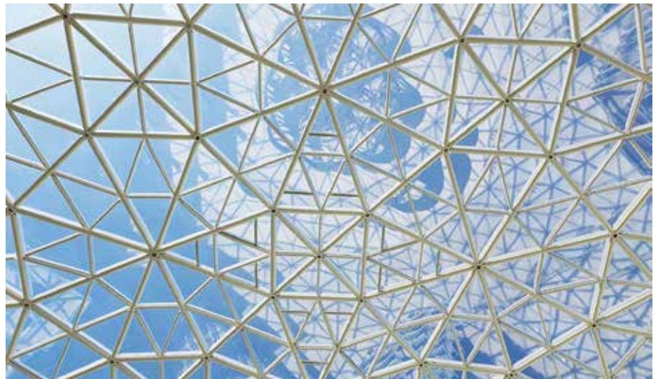
14b. Alle knopen met identieke platen, lassen en boutdiameters voor productie.
