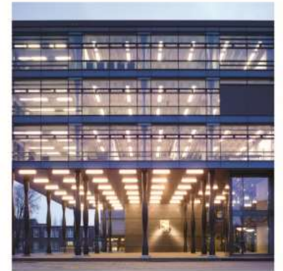
3.6: Voorbeeld van interactie tussen constructeur en architect: de gietijzeren kolommen bij ROC van Twente Hengelo
