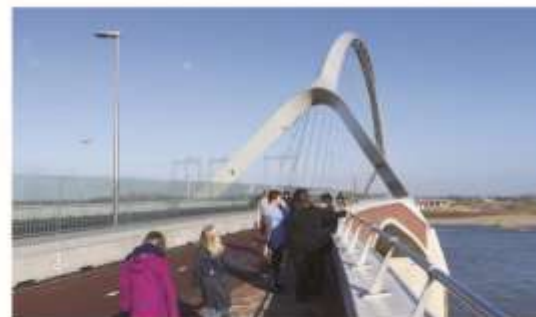
3.4: Hoogbrug (oefeningsbrug) De Oversteek in Nijmegen van architect-constructeur Laurent Ney, geopend in 2013, met een overspanning van 285 meter
