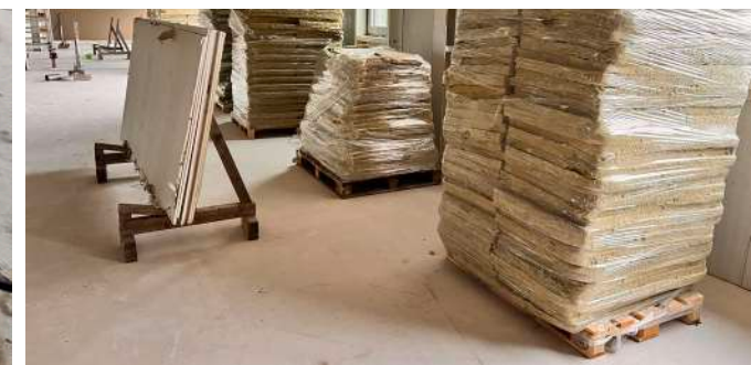
HOUTSKELET FRAMES (100% CIRCULAIR) IPV METAL STUD WANDEN WAARBIJ ALLEEN DE BINNENSTE GIPSPLAAT HERGEBRUIKT ZOU WORDEN
