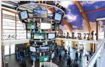
79b Sportcomplex Victorine Plaza tegen de bestaande geamorceerde houten spanten en op een nieuwe staalconstructie zijn staalframebouw vloeren met een toplaag van 4 cm spaanplaat aangebracht.
