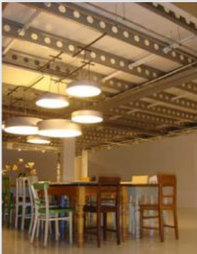
76 De nieuwe vestiging van kinderkledingzaak Tumble in d'ry in Amsterdam heeft een industrieel uiterlijk, passend bij de nieuwe huistijl (dankzij een tussenverdieping met de staalprofielen (rechtstreeks tegen en op de bestaande constructie) nog in het zicht.
