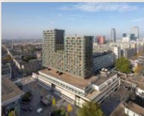
76 Woongebouw De Karel Doorman met staalframe-beton parkeerdekken (Foto: Ossip van Duivenbode)
