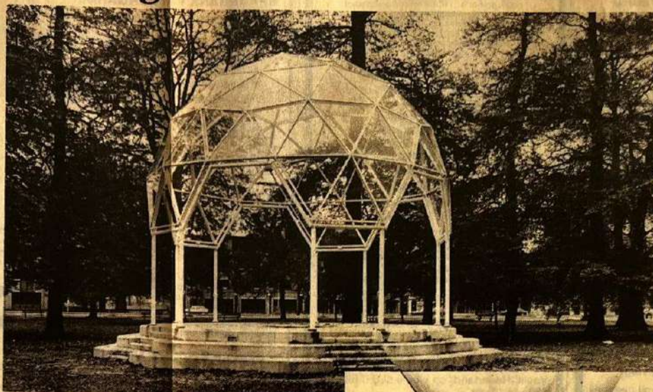
Muziekpaviljoen in de Haarlemmerhout naar ontwerp van ir. Wiek Rölting uit 1983. Een voorbeeld van perfecte samenwerking tussen architect en constructeur (ir. Mick Eckhout) waarbij een ruimtevakwerk is toegepast.
