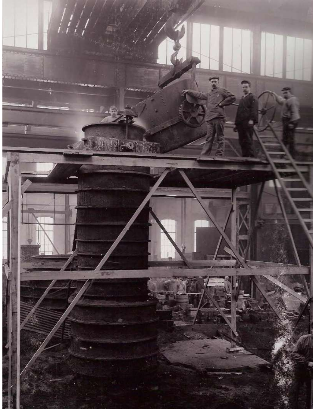
Gieting van een wals in de middelste hal van de Ketelmakerij, ca. 1905. Bron: Archief Werkspoormuseum.
