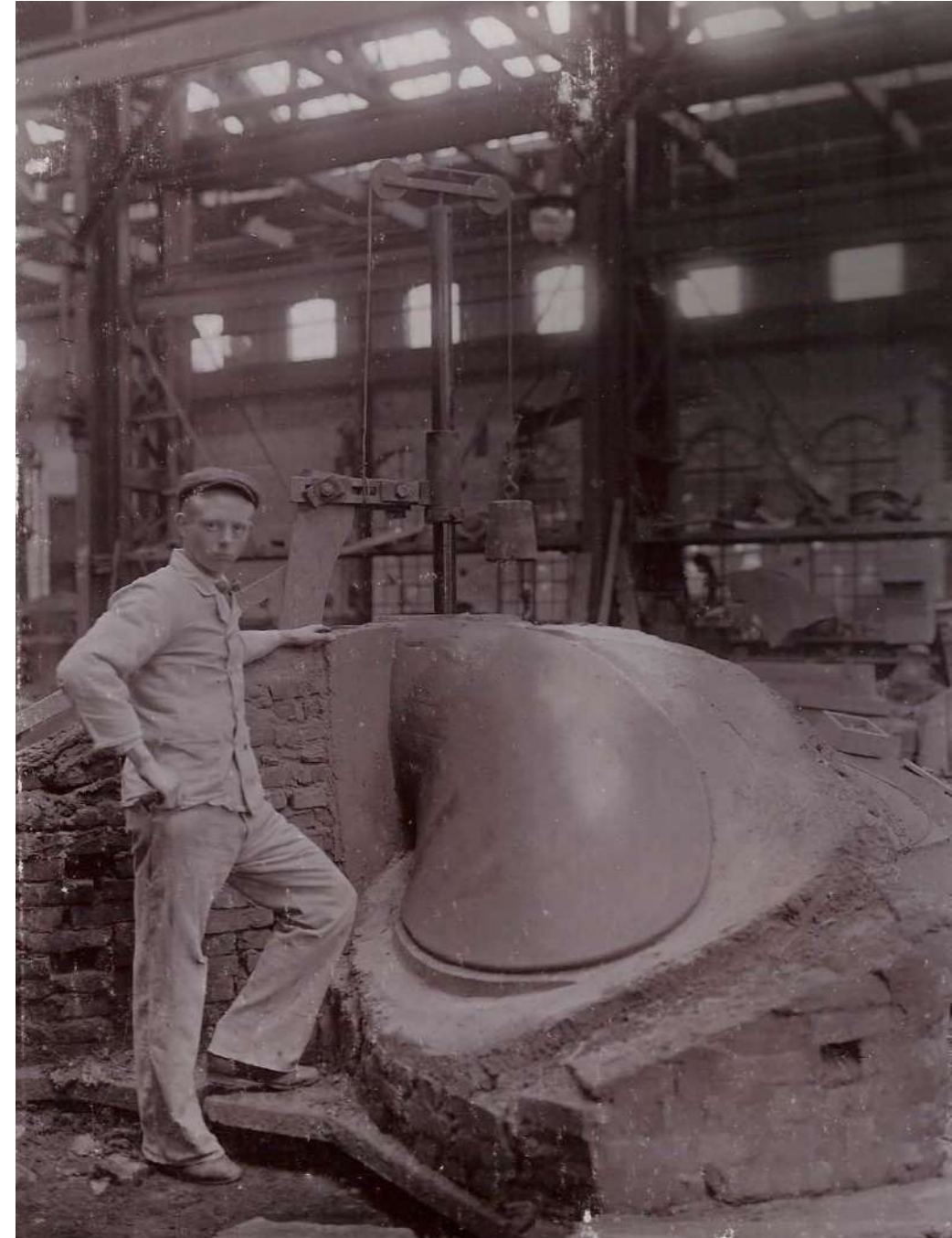
Vorming van een schroef in de middelste hal van de Groote Gieterij, ca. 1905. Bron: Archief Werkspoormuseum.
