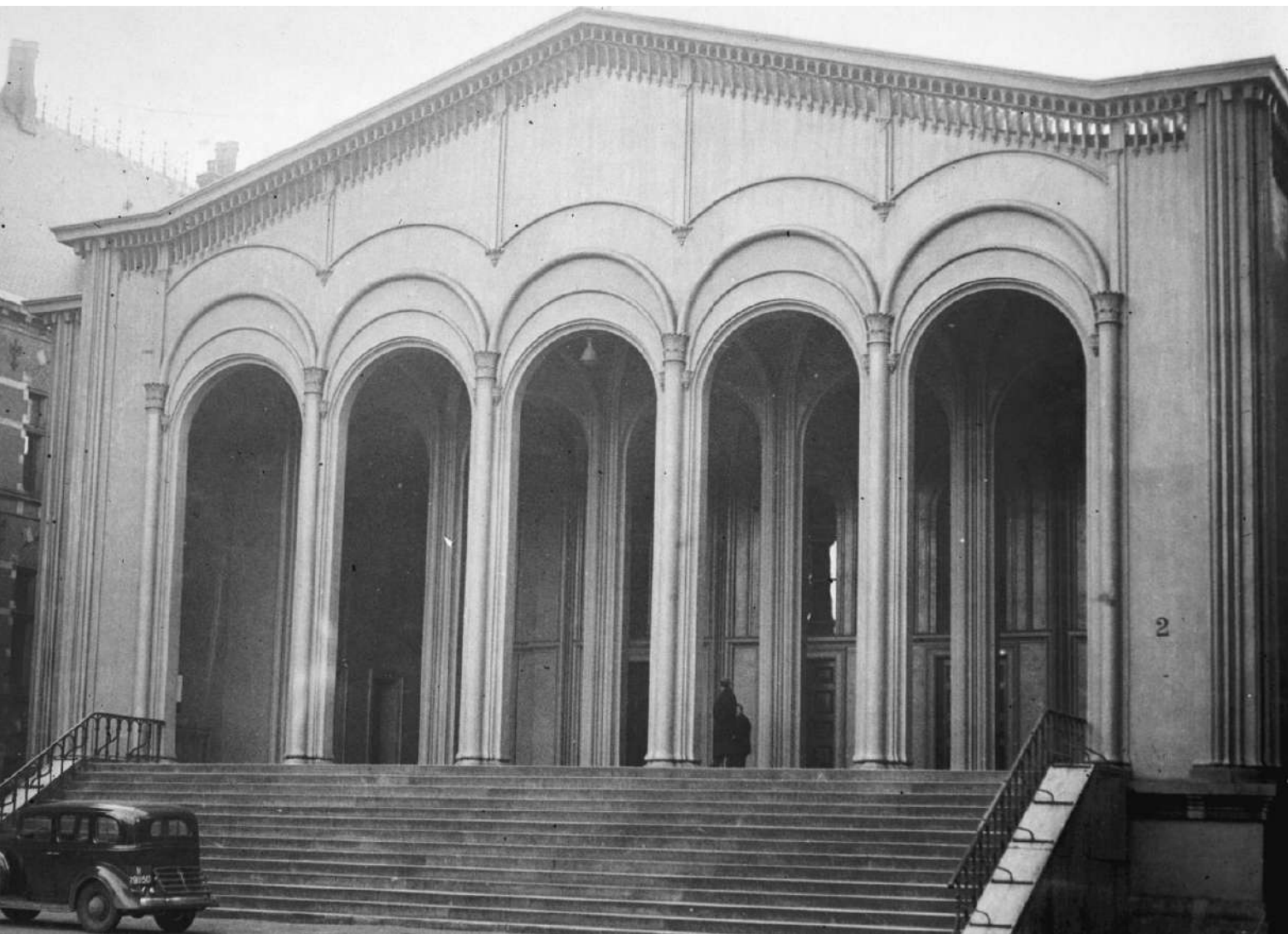
HOGHE RAAD MET GIETIJZEREN GEVEL, 1860
