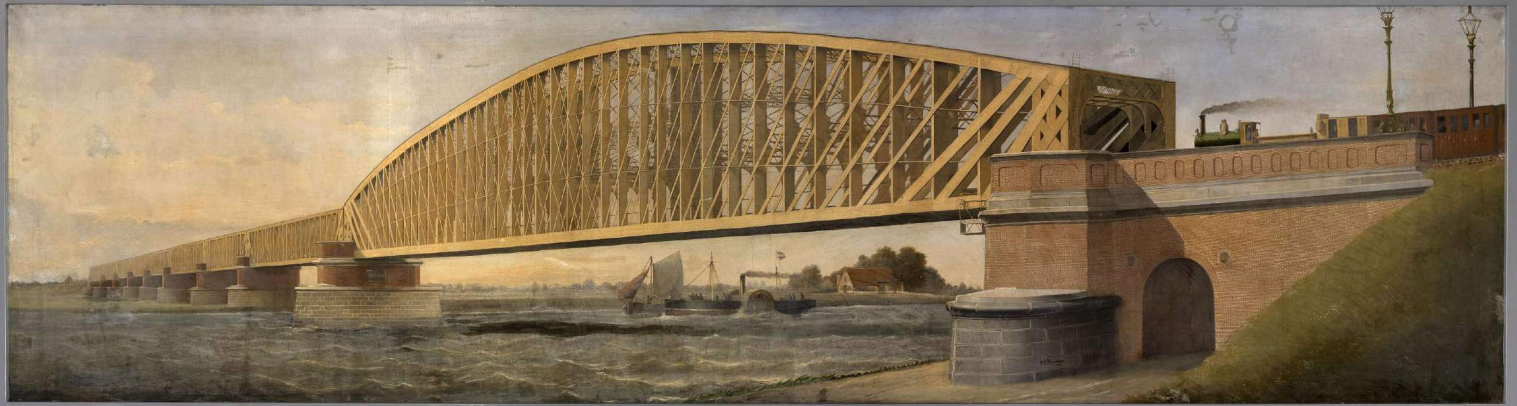
Spoorbrug - Culemburg. 1868 - 1869 Lengte van 154 m verre overspanning 85 m en 70 m van 50 m
