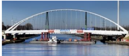
Brug Albertkanaal - Zolder
